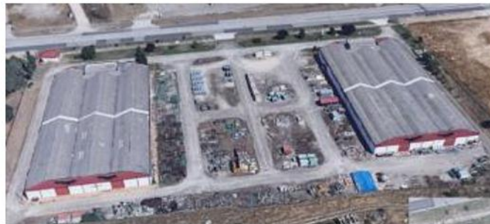
Naves Ayto Burgos (2x3600m2)
